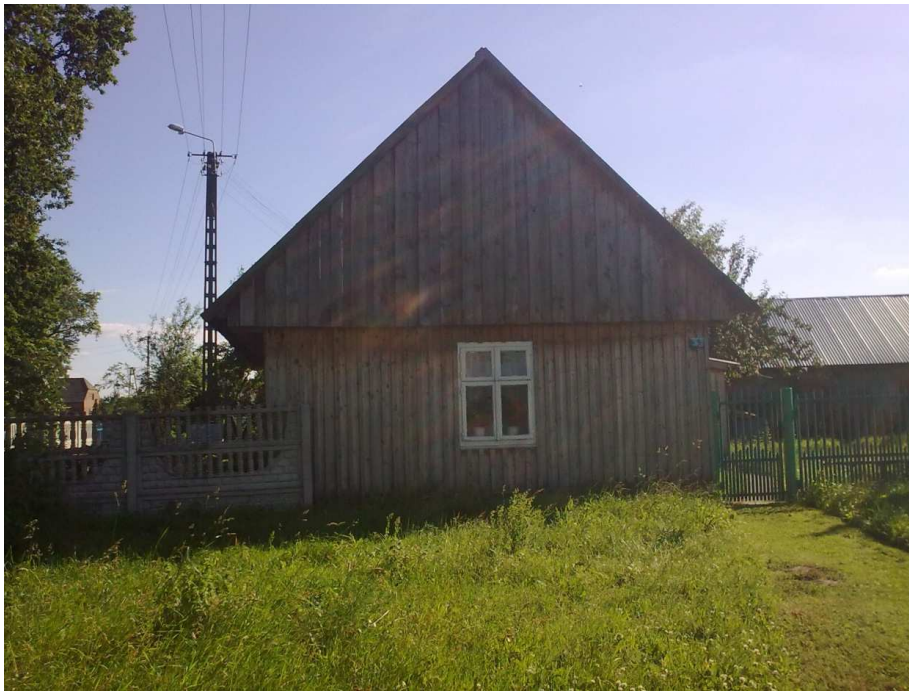
Foto.2. Budynek z okresu przedwojennego.
