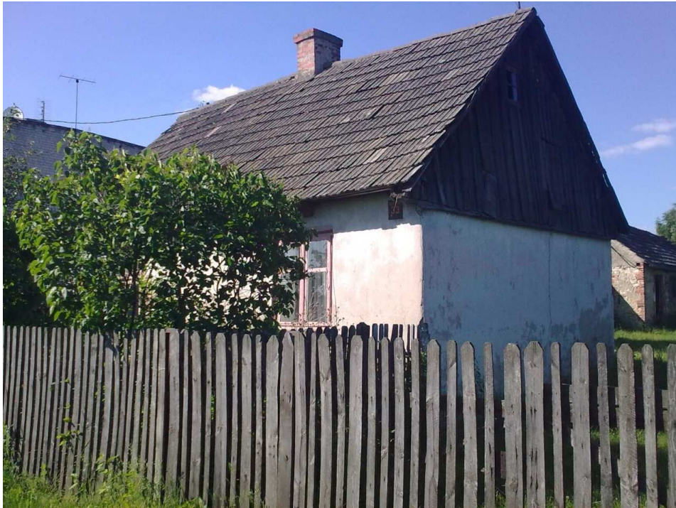
Foto.1. Budynek z okresu przedwojennego.
