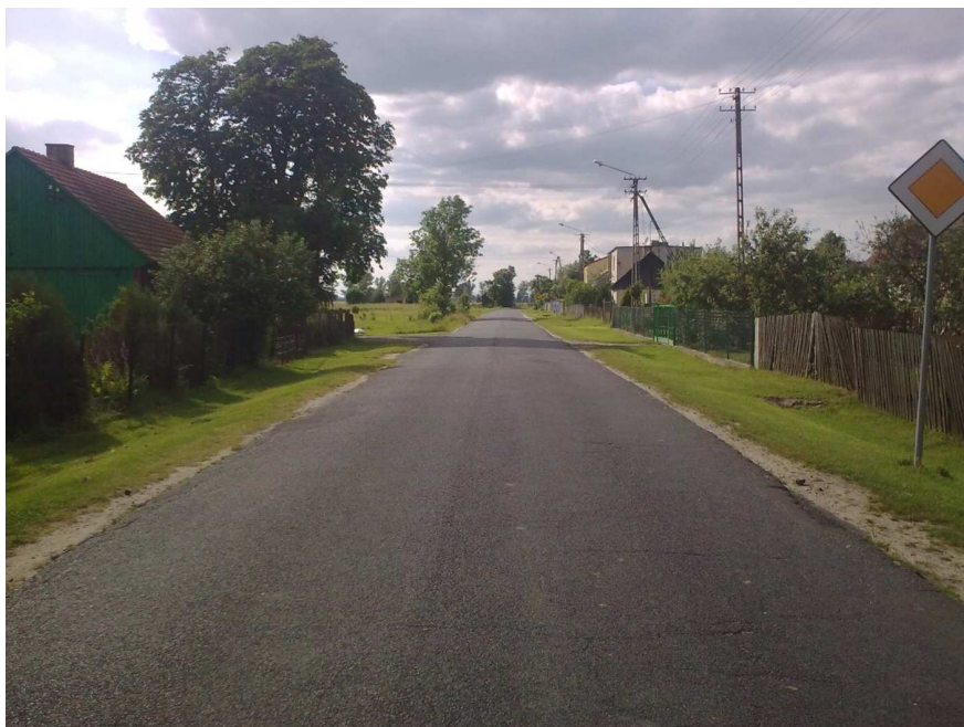
Foto.5. Droga powiatowa, brak chodników.
