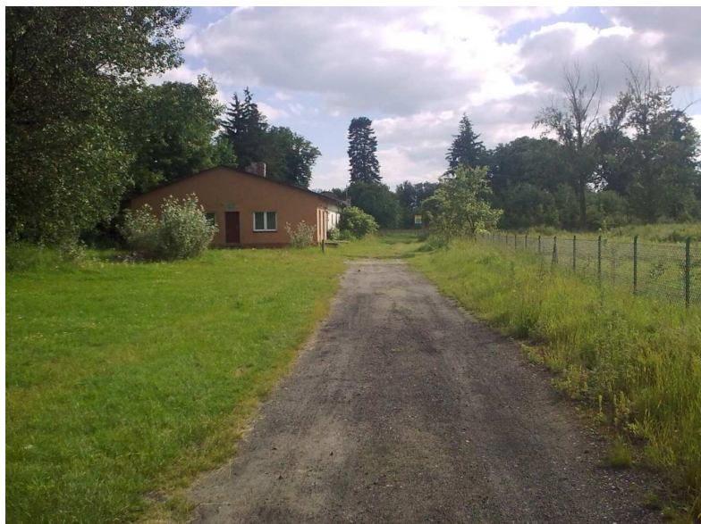
Foto.8. Droga dojazdowa do Budynku Klubu LKS „Park” Starzenice.
