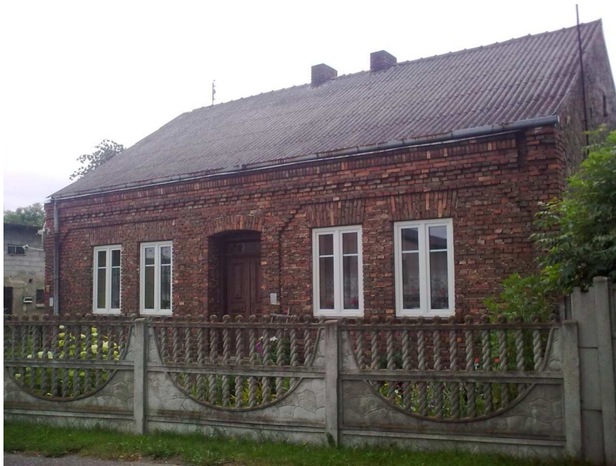
Foto.3. Budynek z okresu przedwojennego
