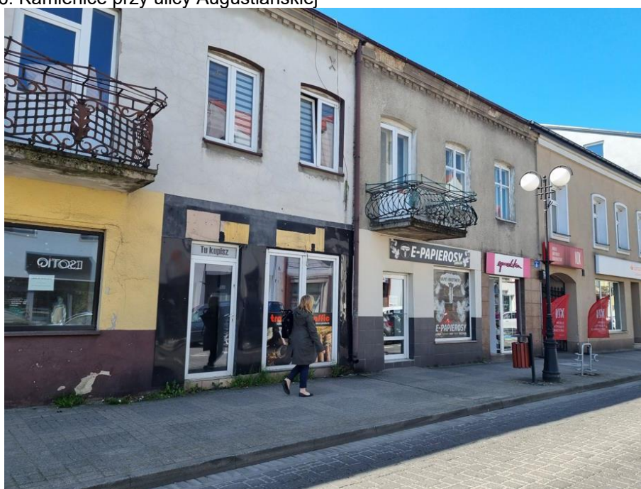
Fotografia 36. Kamienice przy ulicy Augustiańskiej
