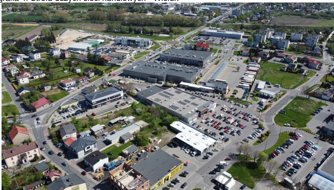
Fotografia 4. Strefa dużych sieci handlowych - Wieluń
