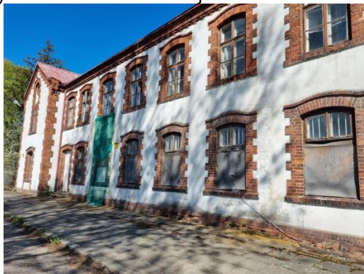
Fotografia 29. Nieużytkowany obiekt na terenie starej cukrowni
