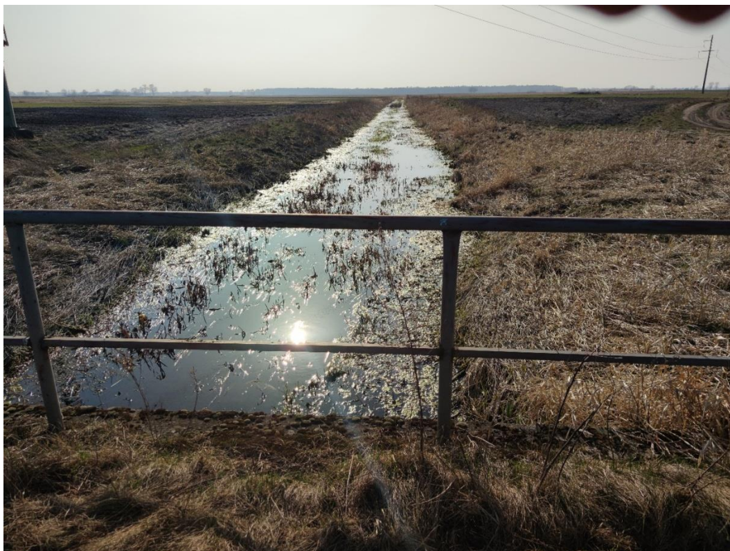
Fot.5. Widok na ciek Kurów – Piaski poniżej przepustu na drodze gruntowej. Przepust betonowy rurowy 2 szt. o średnicy \Phi 1200 mm, L = 10m. Miejsce wlotu do planowanego zbiornika wodnego.
