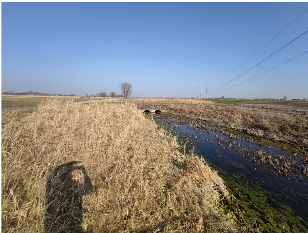
Fot.3. Widok na ciek Kurów – Piaski powyżej przepustu na drodze gruntowej. Przepust betonowy rurowy 2 szt. o średnicy \Phi 1200 mm, L = 10 m.
