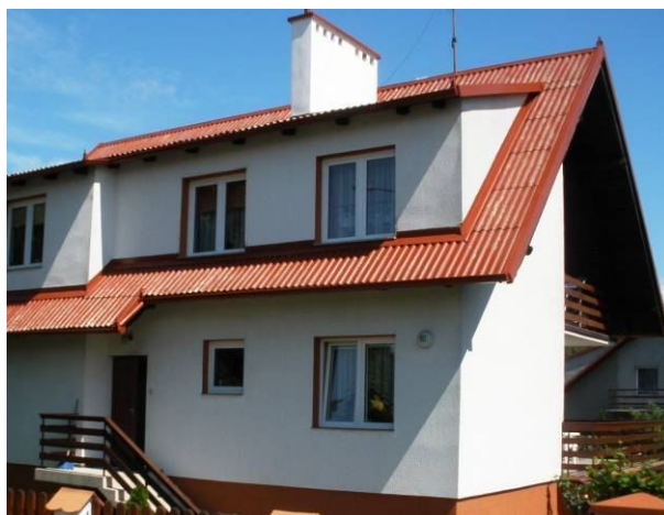
Rys. 5. Przykład zabezpieczenia wykonanego powłoką malarską.
