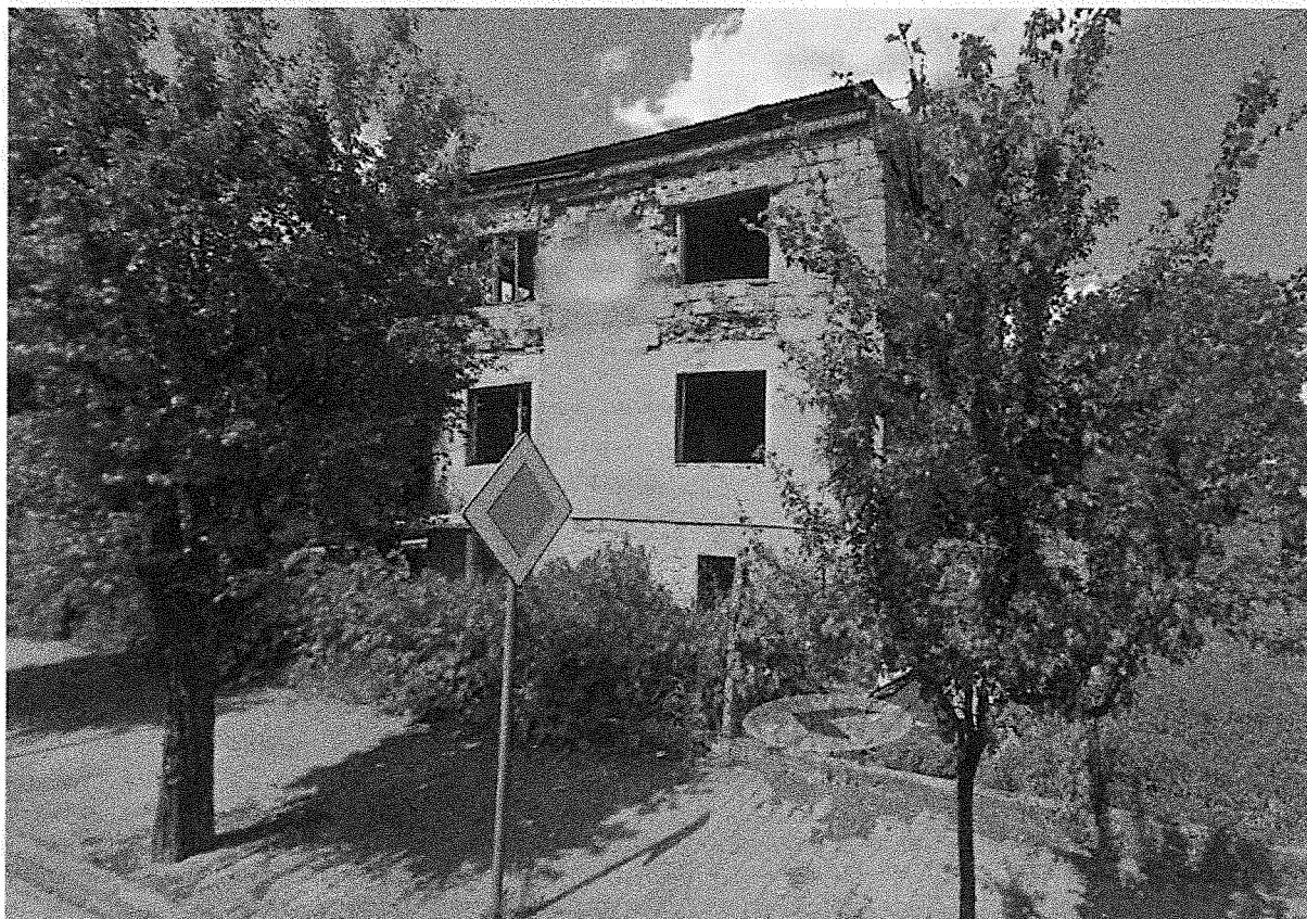
Budynek przy ul. Mokrej 12
