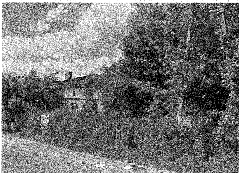
Budynek przy ul. Powstańców 1863 r.
