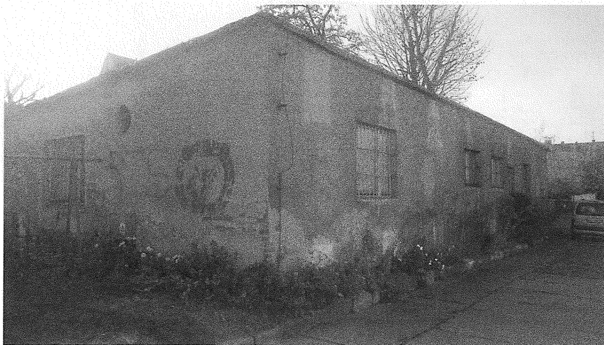
Stan przed rozbiórka
