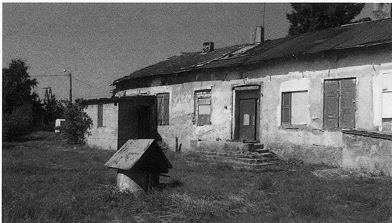
Stan przed rozbiórka
