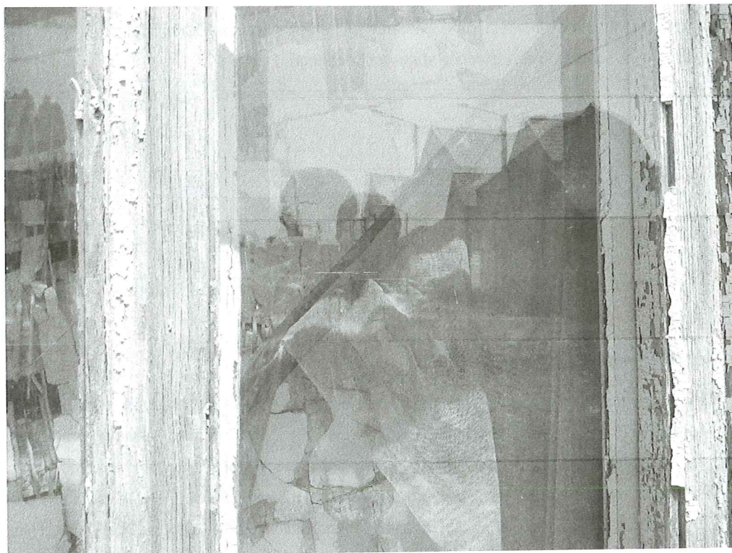
Budynek zachodni – zniszczona stolarka okienna, zarwany strop pod dachem
