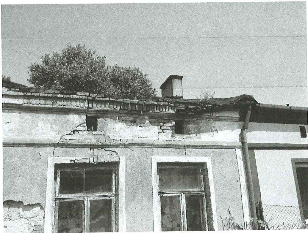
Uszkodzenia ścian – budynek zachodni
