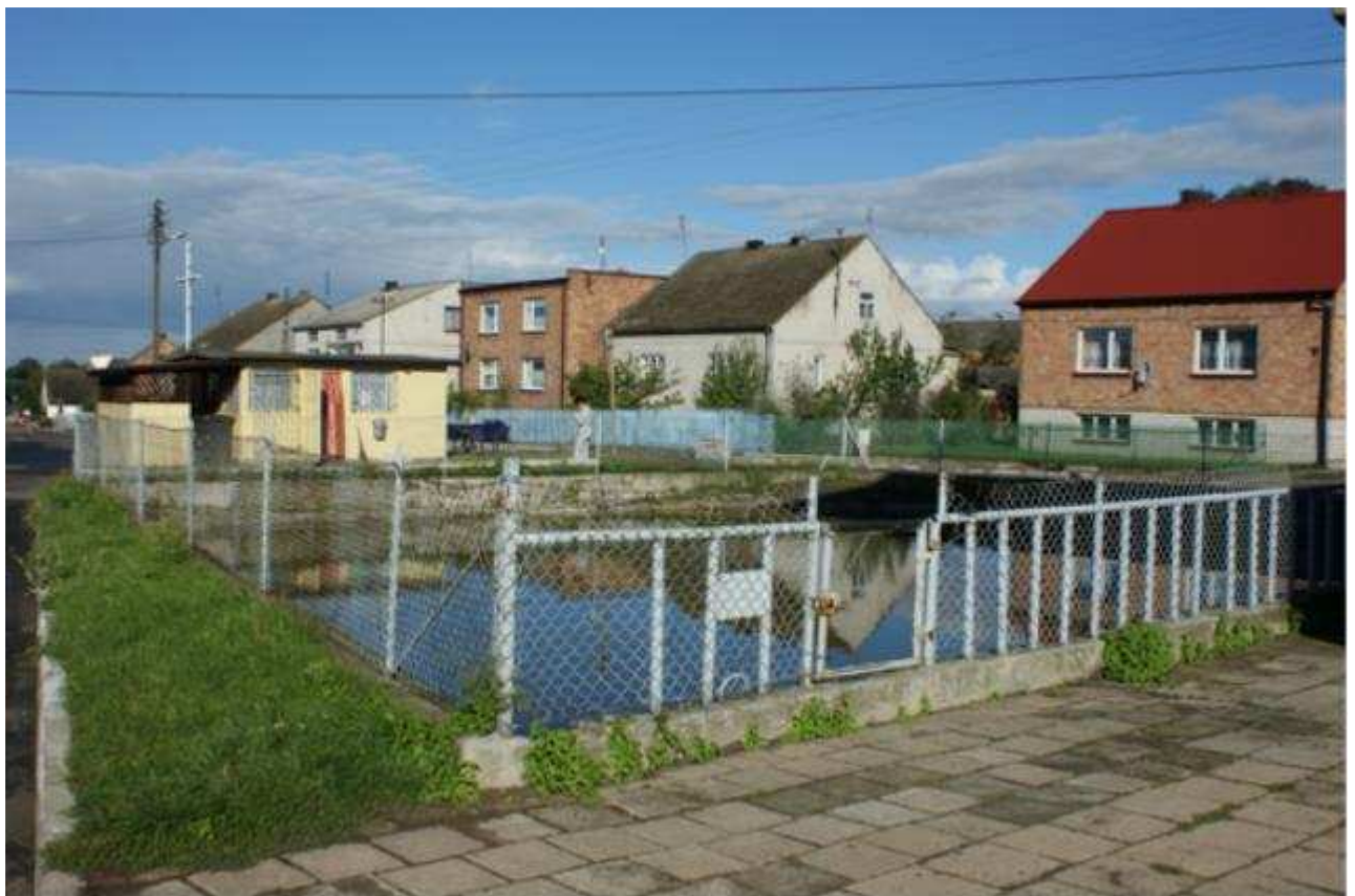
Fot. 1 Zbiornik przeciwpożarowy
