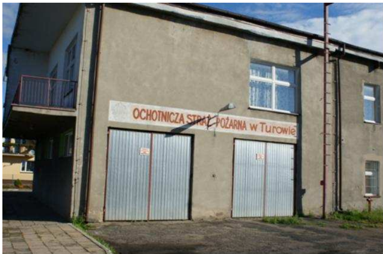
Fot. 3 Budynek Ochotniczej Straży Pożarnej w Turowie
