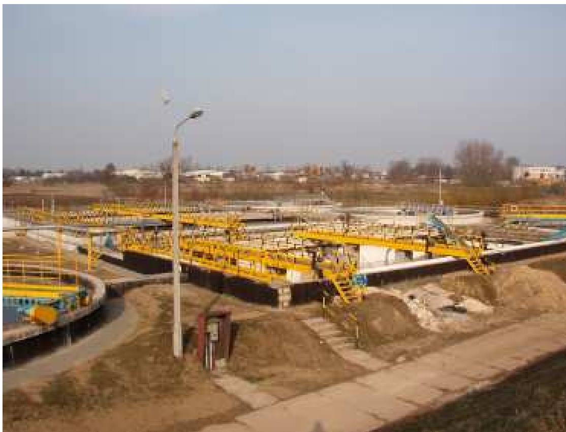
Widok ogólny oczyszczalni ścieków
