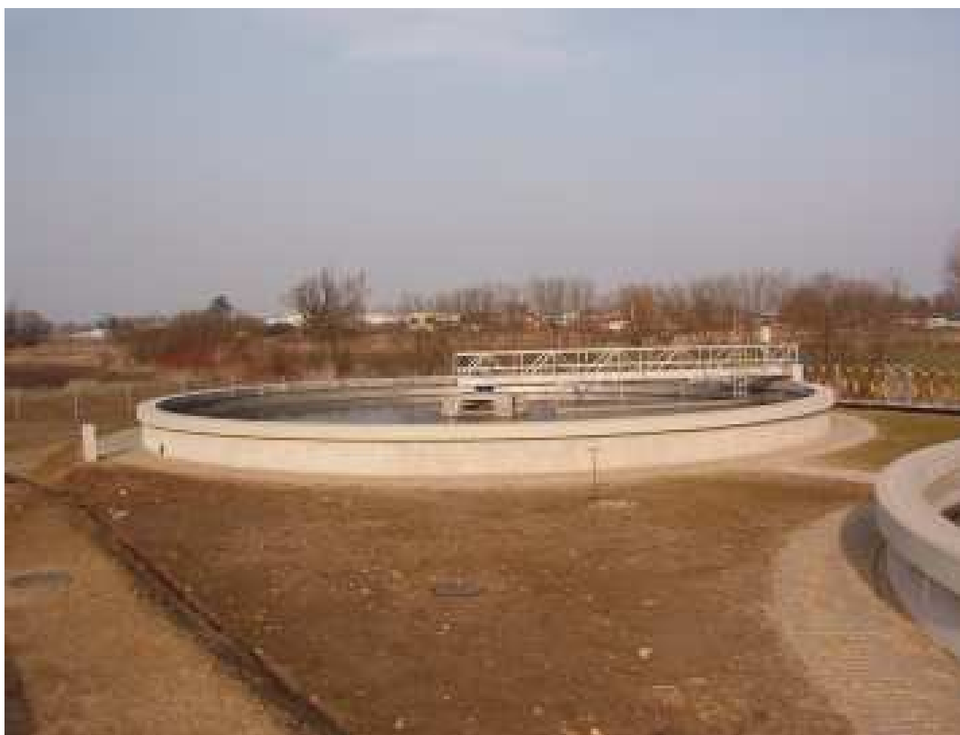
Widok komory napowietrzania
