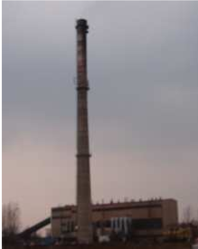
Ciepłownia Miejska w Wieluniu
