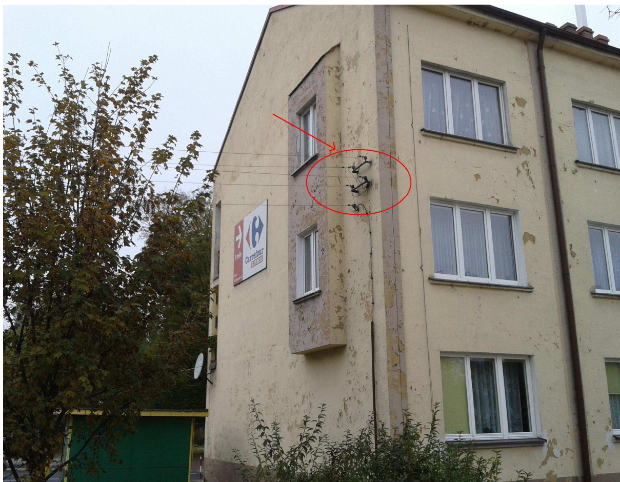
Widok ściany szczytowej z przyłączem napowietrznym
