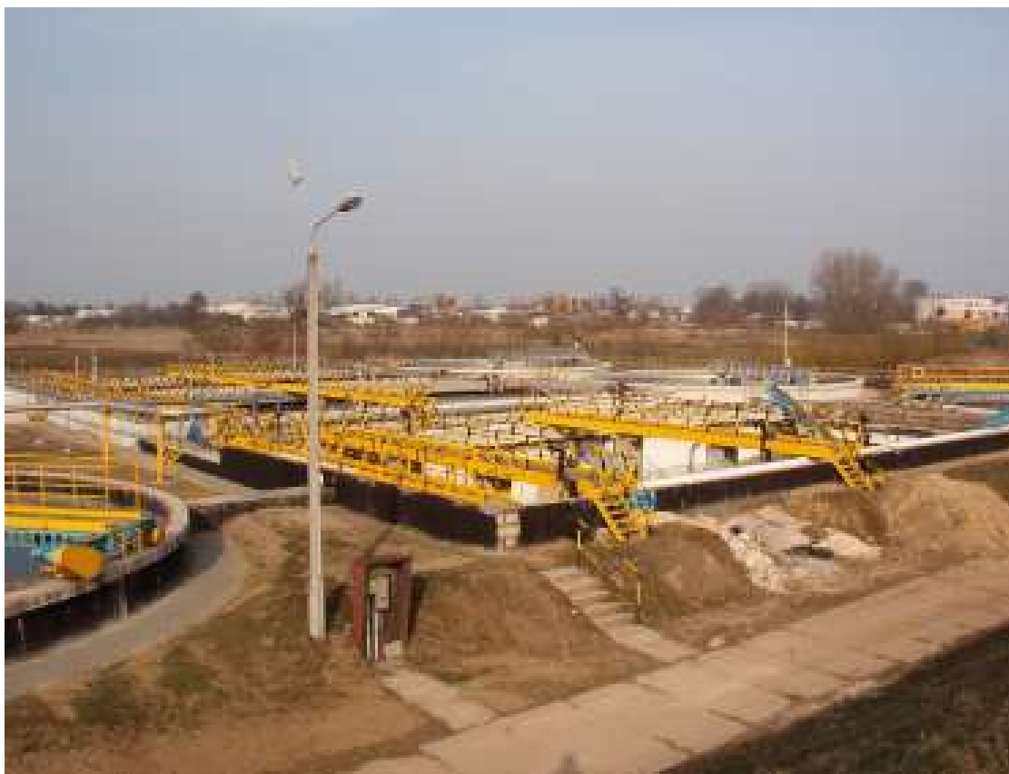
Widok ogólny oczyszczalni ścieków
