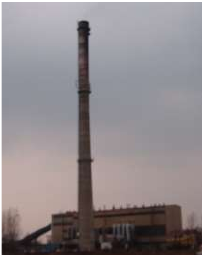
Ciepłownia Miejska w Wieluniu
