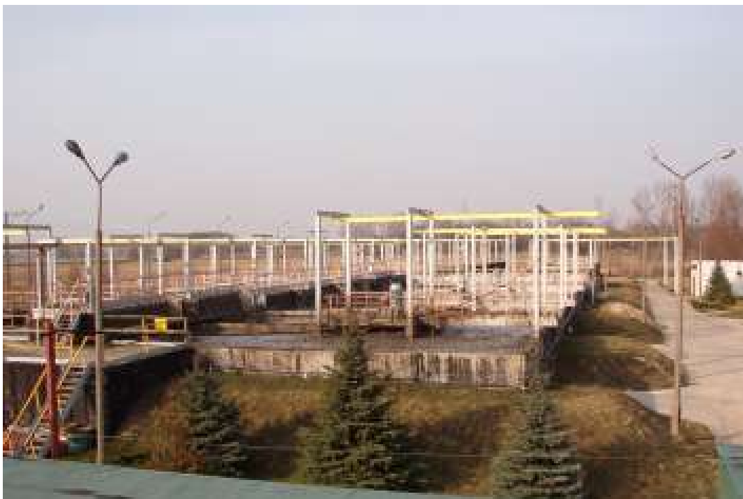
Widok ogólny oczyszczalni Spółdzielni Dostawców Mleka
